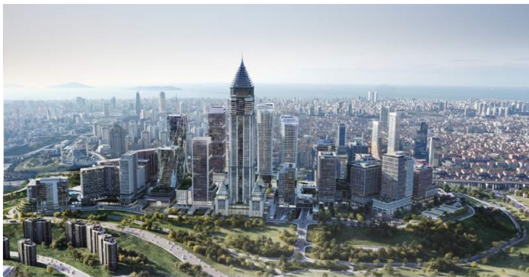
Figure 11 : Photographie prospective du nouveau centre financier d'Istanbul sur la rive asiatique.
