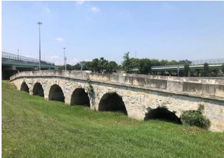
Figure 31: Le pont de Çobançeşme, à l'intérieur de l'échangeur éponyme. Source: Halil Önal, 2021. Google Image .
